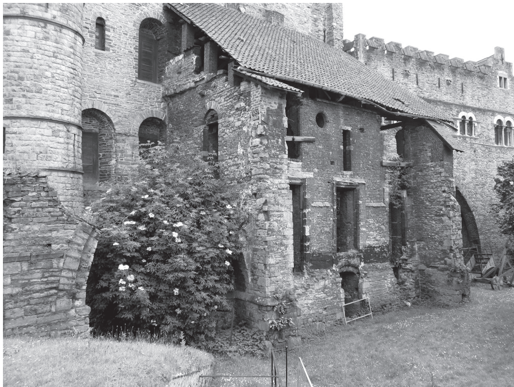
De huidige toestand van de voormalige griffie, aan de noordzijde van het Gravensteen te Gent. Foto J. Verfaillie, 2013.
